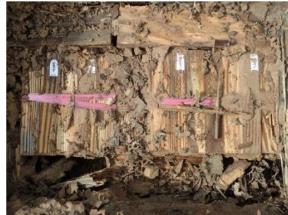
埋設の状況（2年経過後）
